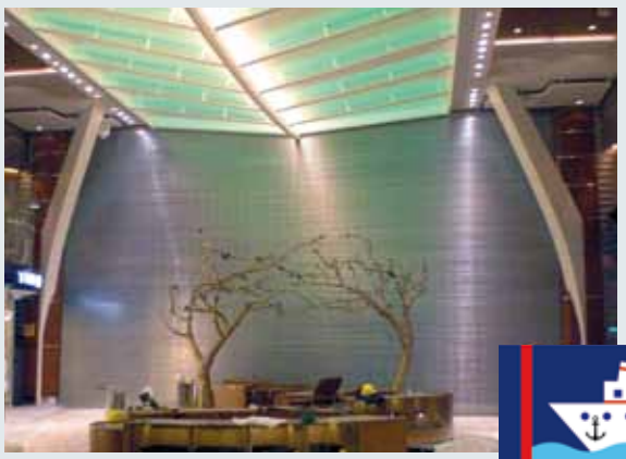
Пожарна защита на ролетна вратата A60 в търговски център на круизен лайнер 15 x 8,75 m
