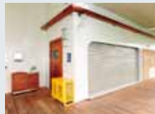
Пожарна защита на ролетна вратата A60 в търговски център на круизен лайнер 15 x 8,75 m
