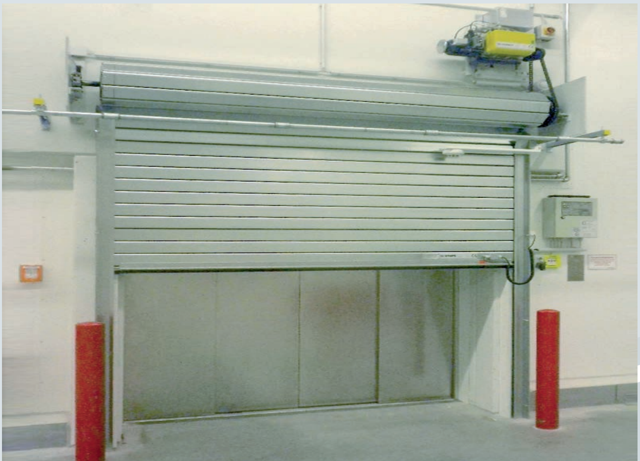
Aqua-Steel® T90, einwandiges Feuerschutzrolltor mit Sprühwasserbeaufschlagung
