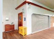
Porte industrielle roulante coupe-feu A60 dans une rue commerçante d'un bateau croisière 15 x 8,75m
